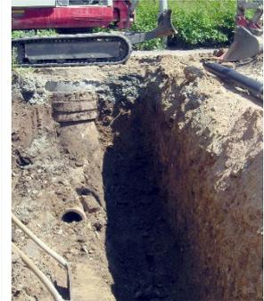
Kabelbeschädigung durch Minibagger
