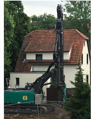
Sondenbohrung für eine Sole-Wasser-Wärmepumpe
