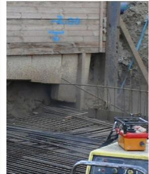
Verschmutzung der Bewehrung der Bodenplatte
