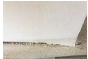
Randdämmstreifen über Estrich abgeschnitten
