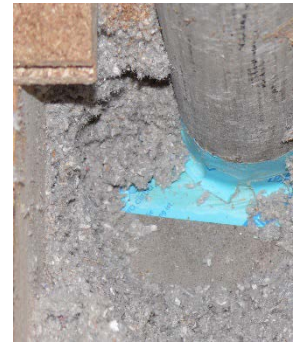
Durchfeuchtete Zellulosedämmung
