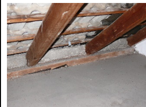
Oberste Geschossdecke, nicht gedämmt
