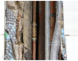
Ungedämmte Leitungsstränge
