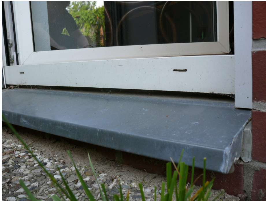
Abb.1: Beispiel einer nicht barrierefreien Terrassentür
