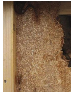
Bauteilöffnung an einer Außenwand in einem Fertighaus
